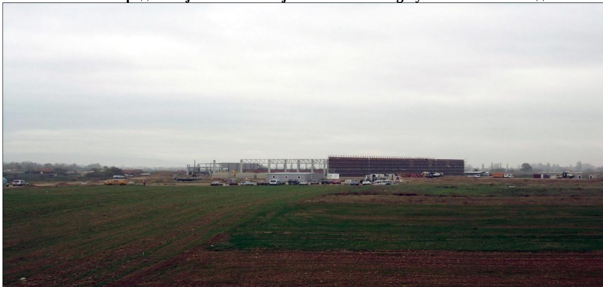
Слика 2. Изградња објекта компаније “ LEONI Wiring Systems Southeast “ д.о.о.
