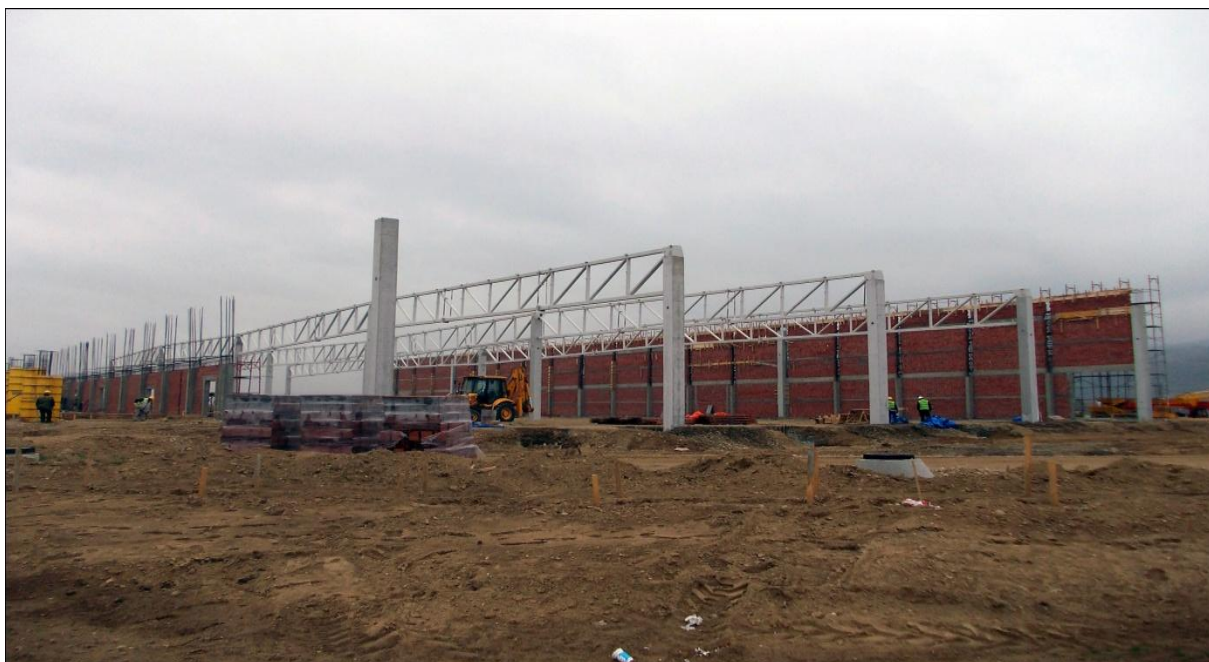
Слика 1. Изградња објекта компаније "LEONI Wiring Systems Southeast" д.о.о.
